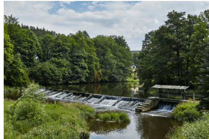
Eines von vielen Querbauwerken an der Weißen Elster. Für Wanderfische wird es hier schwierig. Mit der Auszeichnung zur Flusslandschaft des Jahres könnte gezielt auf diese Probleme hingewiesen werden. Bild: DAFV
