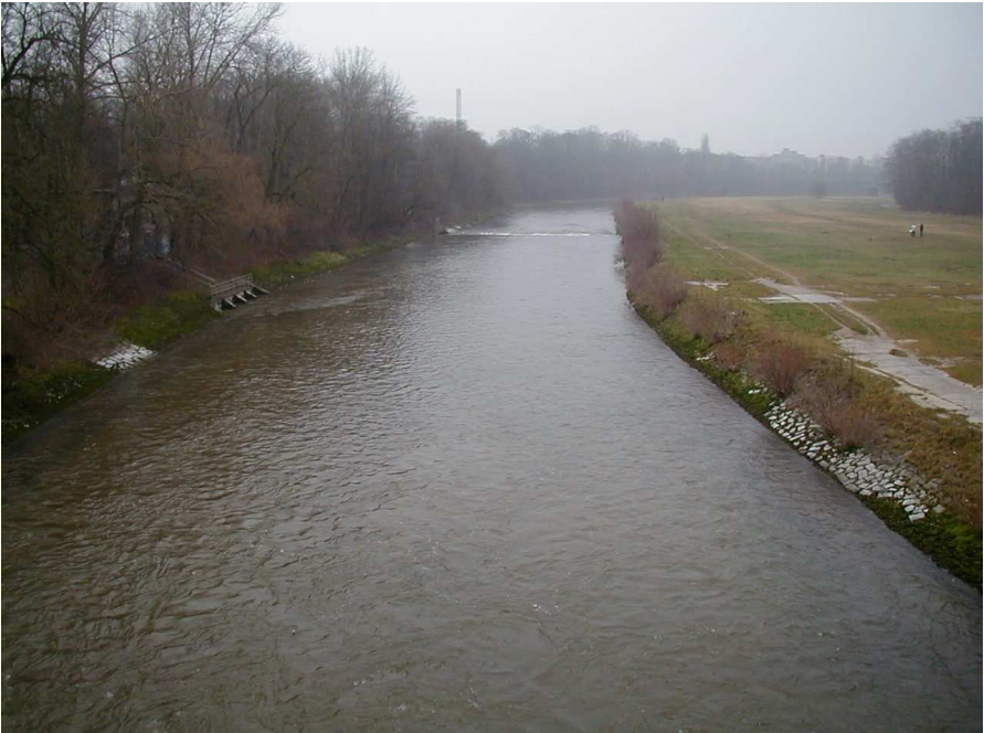
Abb. 3: Kanalartiges Gewässerbett der Isar im innerstädtischen Bereich vor Durchführung der naturnahen Flussbaumaßnahmen (Foto Wasserwirtschaftsamt München).
