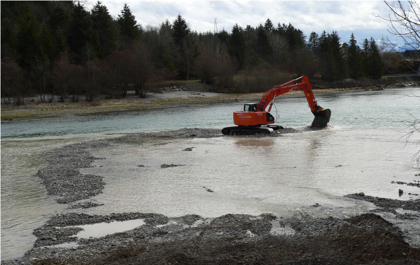
Abb. 1: Bau eines Kies-Laichplatzes bei Dessau am Lech (J. Schnell)
