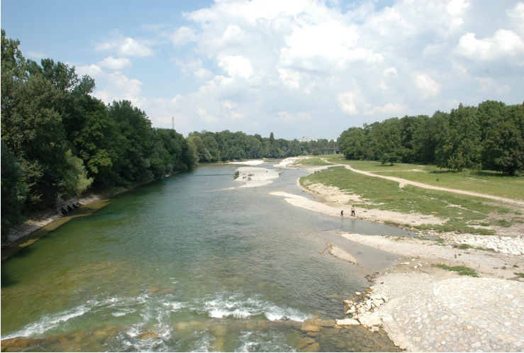
Abb. 4: Aufgeweitetes strukturreiches Gewässerbett der Isar im innerstädtischen Bereich nach Durchführung der naturnahen Flussbaumaßnahmen (Foto Wasserwirtschaftsamt München).
