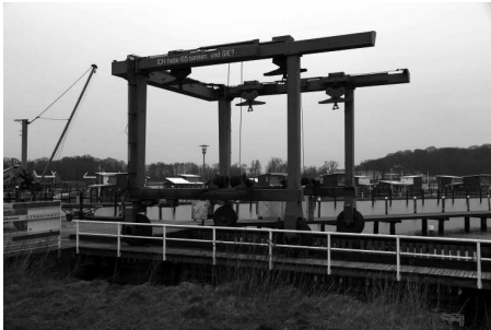
Der Travellift kann bis zu 65 Tonnen heben und wird auch von den Lauterbacher Fischern benutzt.
