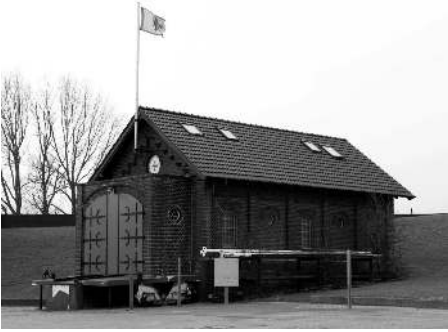
Der Rettungsschuppen der DGzRS.
