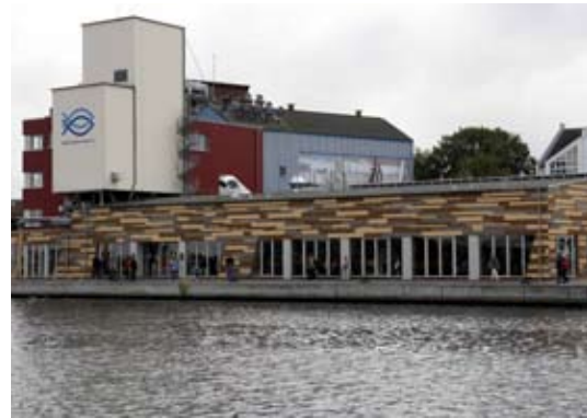
Das Genossenschaftsgebäude und die Fischhalle haben eine neue Fassade erhalten.
